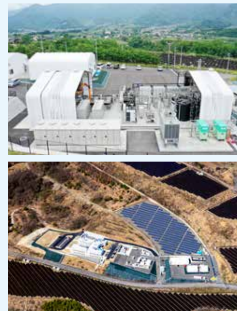
米倉山でグリーン水素を製造するP2Gシステム
